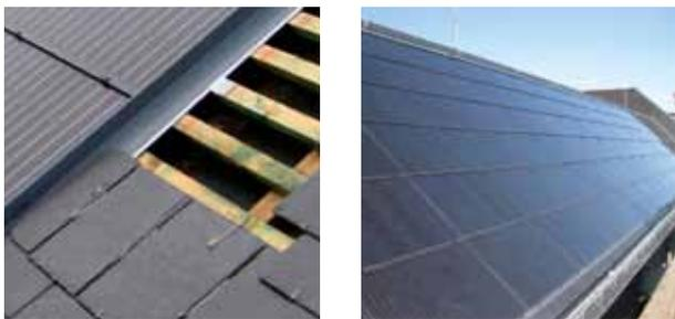
Bei der bis Sommer 2011 fertig installierten dachintegrierten PV Anlage handelt es sich um eine  $72 \text{ kW}_{\text{peak}}$  Anlage mit einer Bruttogesamtfläche von  $551 \text{ m}^2$  und einer Ertragsleistung von  $\pm 65.000 \text{ kWh}$ . Dies entspricht einer  $\text{CO}_2$  Einsparung von  $\pm 35.000 \text{ kg}$ .
